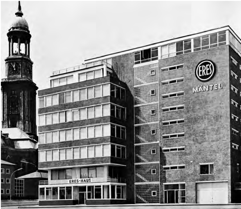
Die neue Produktionsstätte der Firma ERES KG an der Ost-West-Straße 100
