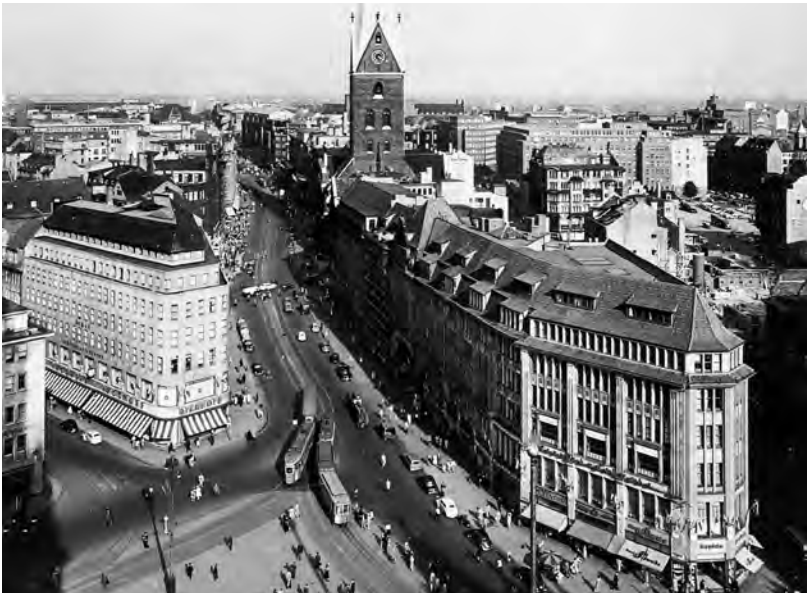
oben: Die Mönckebergstraße nach Kriegsende unten: Die Straße Anfang der 1950er-Jahre nach dem Wiederaufbau, vom Rathausurm aus gesehen
