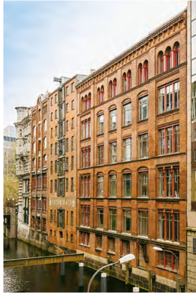
Fleetansicht der alten Fassade
