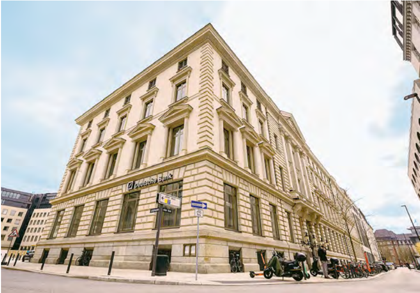
Der Alte Wall mit Blick zum Rödingsmarkt, hier befand sich die erste Firmenniederlassung
