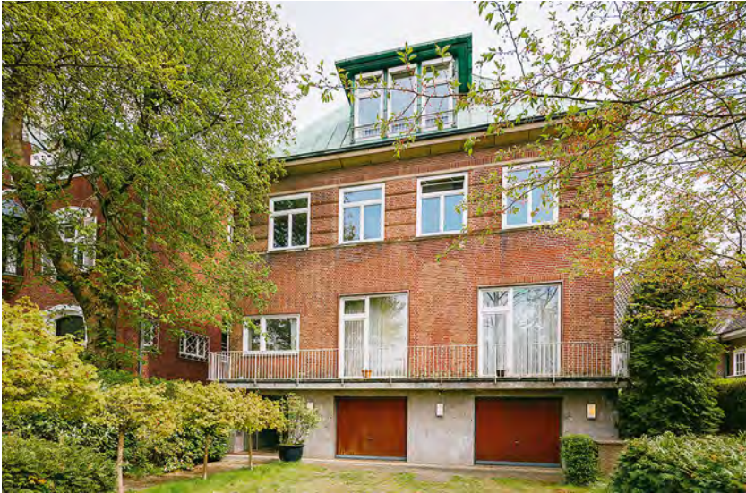
Heutige Ansicht des umgebauten Hauses Leinpfad 58
