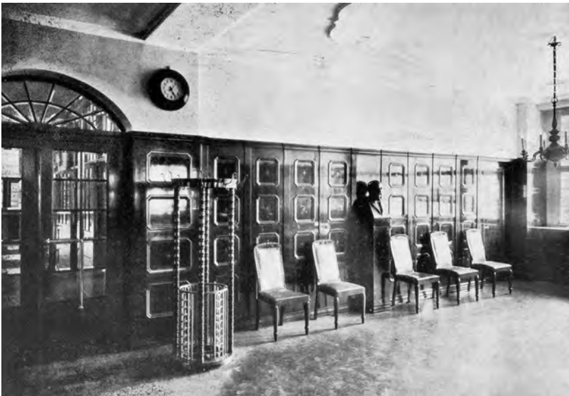
Kontorräume der Angestellten und Warteraum für Besucher, Einkäufer und Vertreter im Rappolthaus 11
