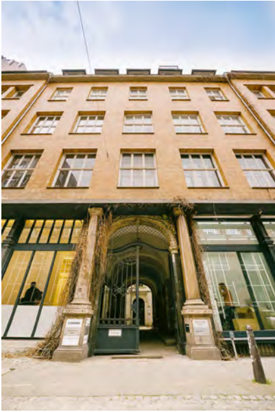
Die Admiralitätsstraße 71/72 mit neuer Fassade
