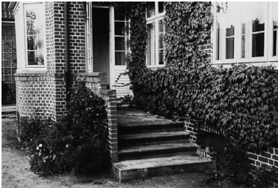
Abb. 57: Treppenstufen zum Garten
