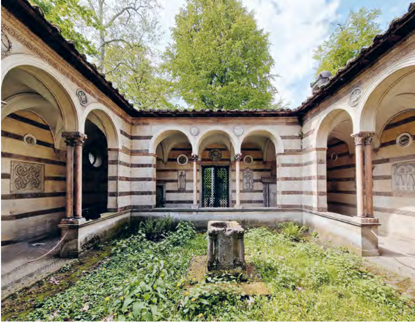
102 Glienicke, Klosterhof, Innenansicht, Blick nach Westen
