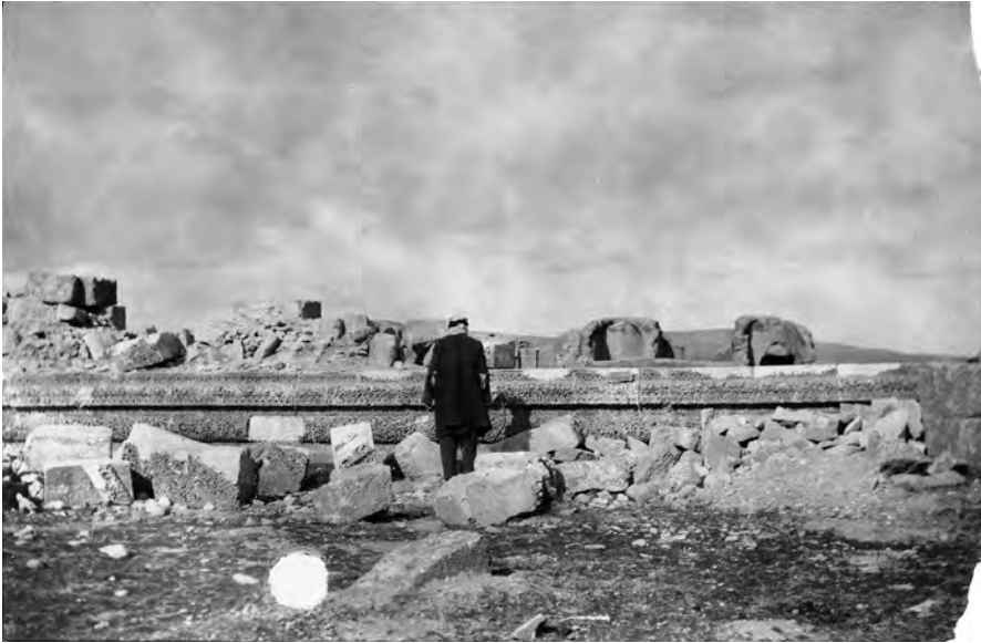
Abb. 6: Von Gertrude Bell angefertigte Fotografie ihres Begleiters Ali vor den Überresten der Palastfassade Mschattas.
