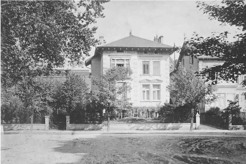
Das Haus von Ehepaar Troplowitz am Eidelstedter Weg 42, wie nun die Adresse lautet: freundlich begrünt, 14 Jahre nach seinem Bau. Nur drei Jahre später sollten die Besitzer ein neues Heim beziehen.
