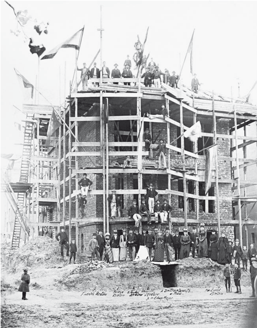
Das Richtfest für die Villa am Lokstedter Weg, 1892. Im Zentrum die Bauherren, Ehepaar Tropolwitz. Hinter Gertrud Bauunternehmer H. E. August Meyer; (vom Betrachter aus) links von ihr Jungarchitekt Christian Leopold Strelow, von dem zahlreiche Familienmitglieder versammelt sind.
