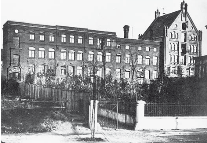
Das rasante Wachstum der Produktionsanlagen von P. Beiersdorf & Co.: Der kleine, niedrigere Abschnitt ist die ursprüngliche Fabrik von 1892. Im Bild links daneben zunächst der zwölf Meter breite Anbau von 1895, dann die größere Erweiterung von 1897; auf der rechten Seite der 1899 errichtete Speicher
