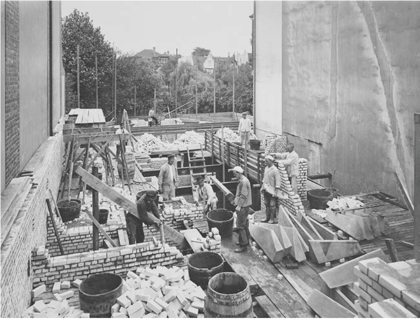
Abb. 30: Die Baustelle auf dem Grundstück Heilwigstraße 116. Am 25. August 1925 wurde der Grundstein der erweiterten K. B. W. gelegt.
