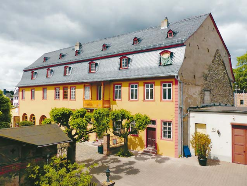
Abb. 7. Das Brentano-Haus nach der Außensanierung (Foto: privat).
